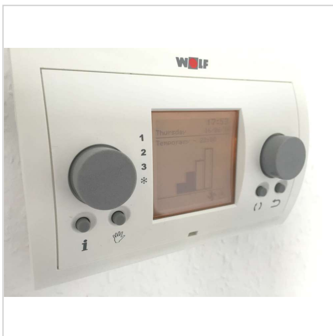
Steuerung Lüftungsanlage
