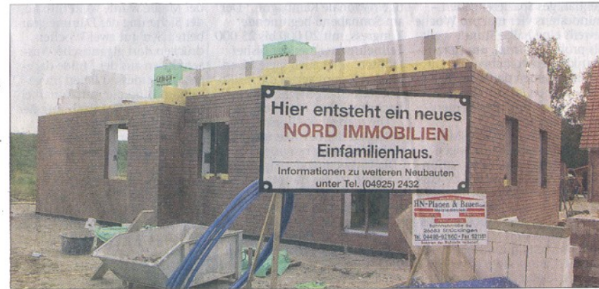
In der Robert Bunsen Straße entsteht dieses Einfamilienhaus.
