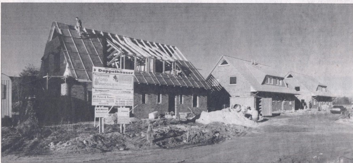
Das vordere Haus ist noch im Rohbau während die beiden hinteren bereits fertiggestellt sind.
