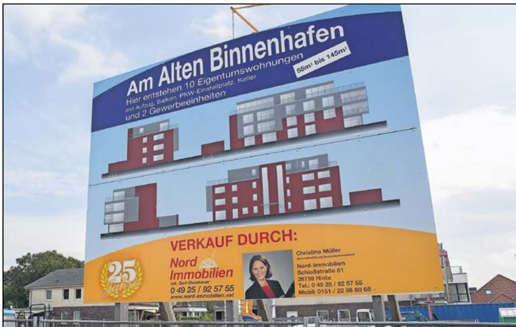
Am Alten Binnenhafen, genauer in der Hermann-Neemann-Straße 3, entsteht dieser Neubau mit Wohn- und Geschäftsflächen.
